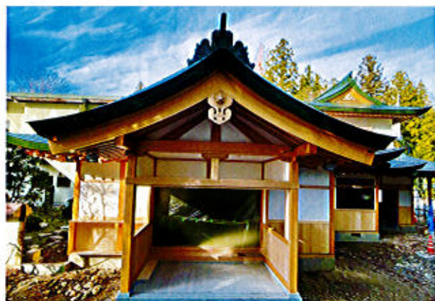
斎館 正面（東側）
