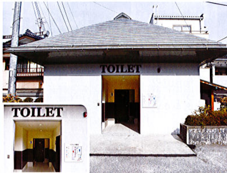
改修後のトイレ
